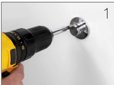
Colocar los tacos a la pared y atornillar la placa de sujeción.
